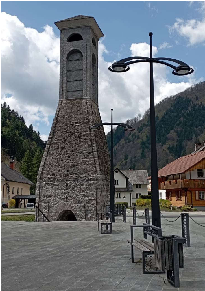
Slika 5: Plavž v Železnikih
